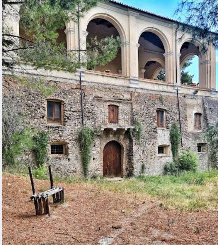
Strutture portanti sotto il porticato.jpg
